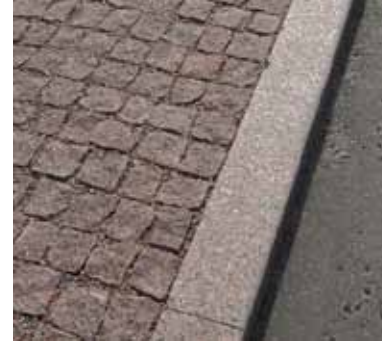
4 / marciapiede porfido posa a file parallele
